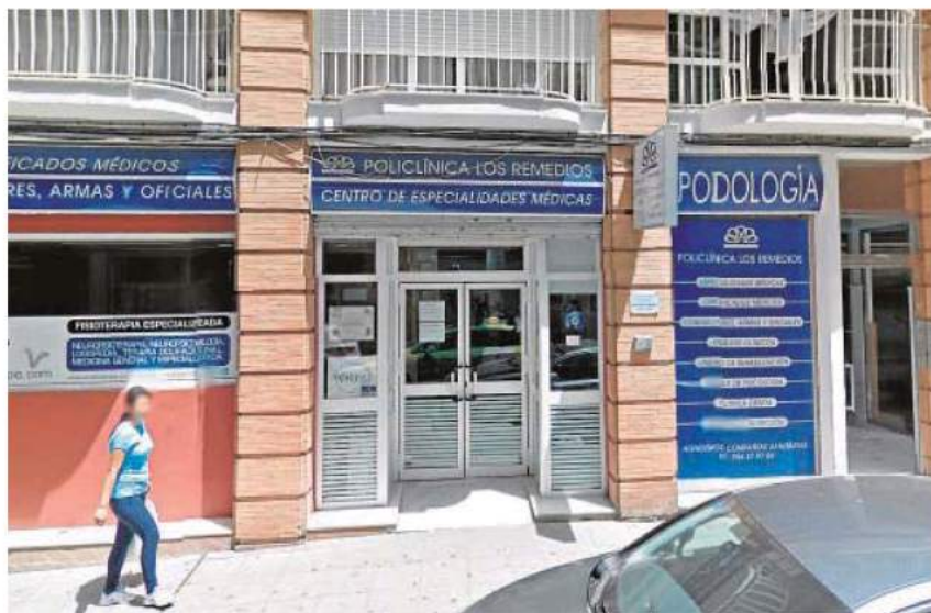
Puerta de la Policlínica Los Remedios, en la calle Fernando IV
